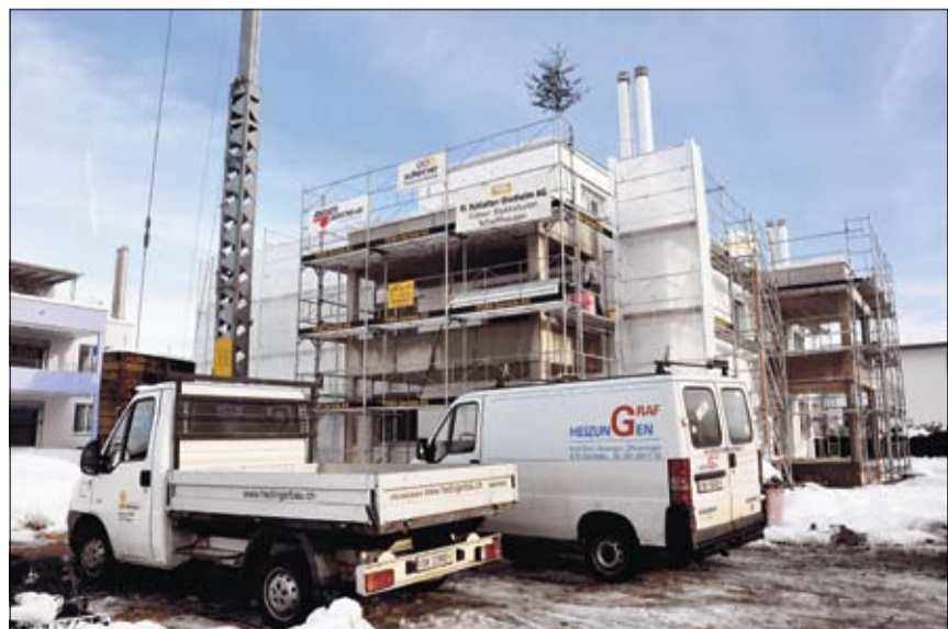
Im und am Haus C sind die Ausbauarbeiten noch voll im Gange. Hier wird die Loggiafarbe ein zartes Pastellgelb sein.
